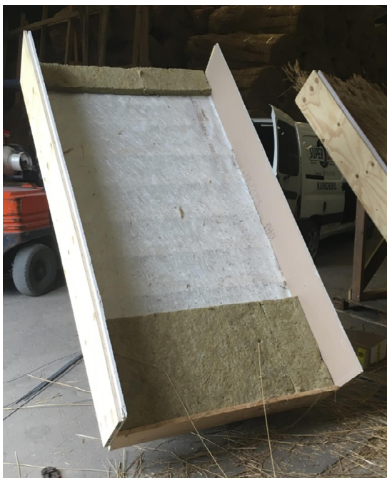
Foto 3: Udlægning af Sepatec og randisolering ovenpå lægtelag (tagmodel 2 og 3).
