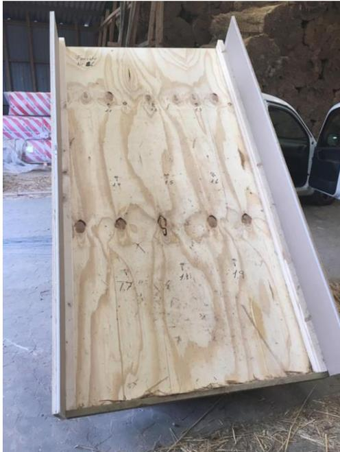
Foto 1: Unterbau in Form eines EI 30-Bauteils aus einem Baustoff, der mindestens D-s2, d2 entspricht (zwei Lagen 18 mm Sperrholz).
