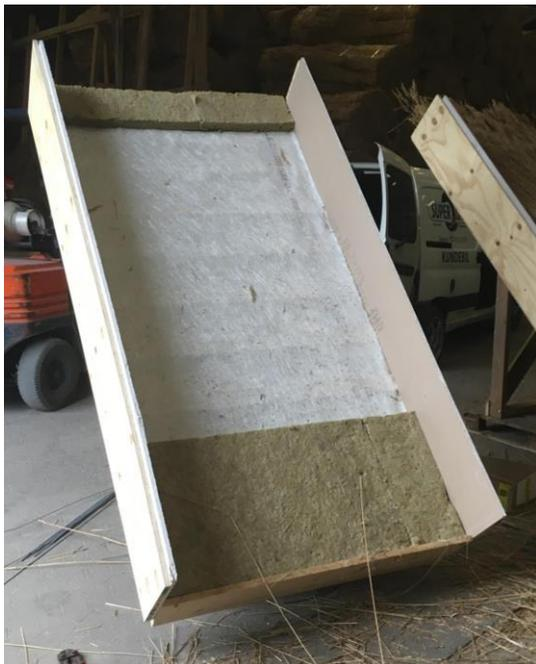
Foto 3: Auslegung von Sepatec und Randdämmung auf der Lattenkonstruktion (Dachmodelle 2 und 3).
